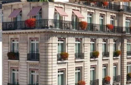
Для отделки фасада архитекторы Густав Умбденсток и Урбан Кассан выбрали белый камень из Комбланшьена, устойчивый к пыли и загрязнениям.
